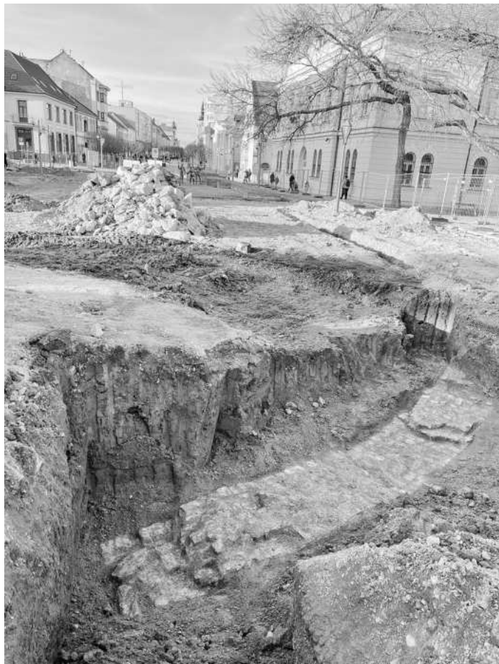
Základy renesančného barbakánu. Foto: E. Hrnčiarik
